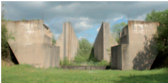
Schleusenruine Wüsteneutzsch – Deutschlands größte Schleusentreppe.
